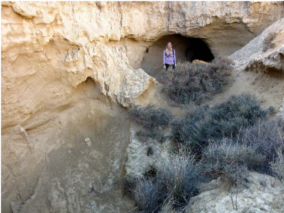
Figura 32. Suelos con material arcilloso fino en la galería-túnel de Las Bodegas 07 y depresión superior con hundimientos adicionales del terreno, que alcanzan -10 m de desnivel.
